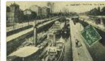
Vue générale des écluses au début du 20 e siècle.
