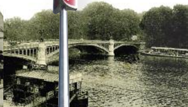
L'ancien pont au début du 20 e siècle.
