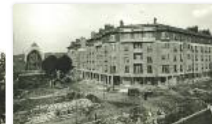
Notre-Dame de la Paix en construction.
