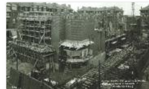
Le centre social Albert Thomas en construction.
