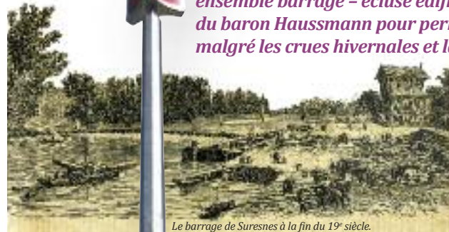
Le barrage de Suresnes à la fin du 19 e siècle.
